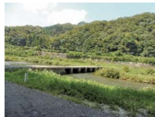
南大河原より北大河原を見る大河原橋
