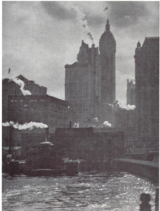
'The City of Ambition' (1910) CAMERA WORK No.36(1911) 変わりゆくニューヨークの象徴ともいべき摩天楼
