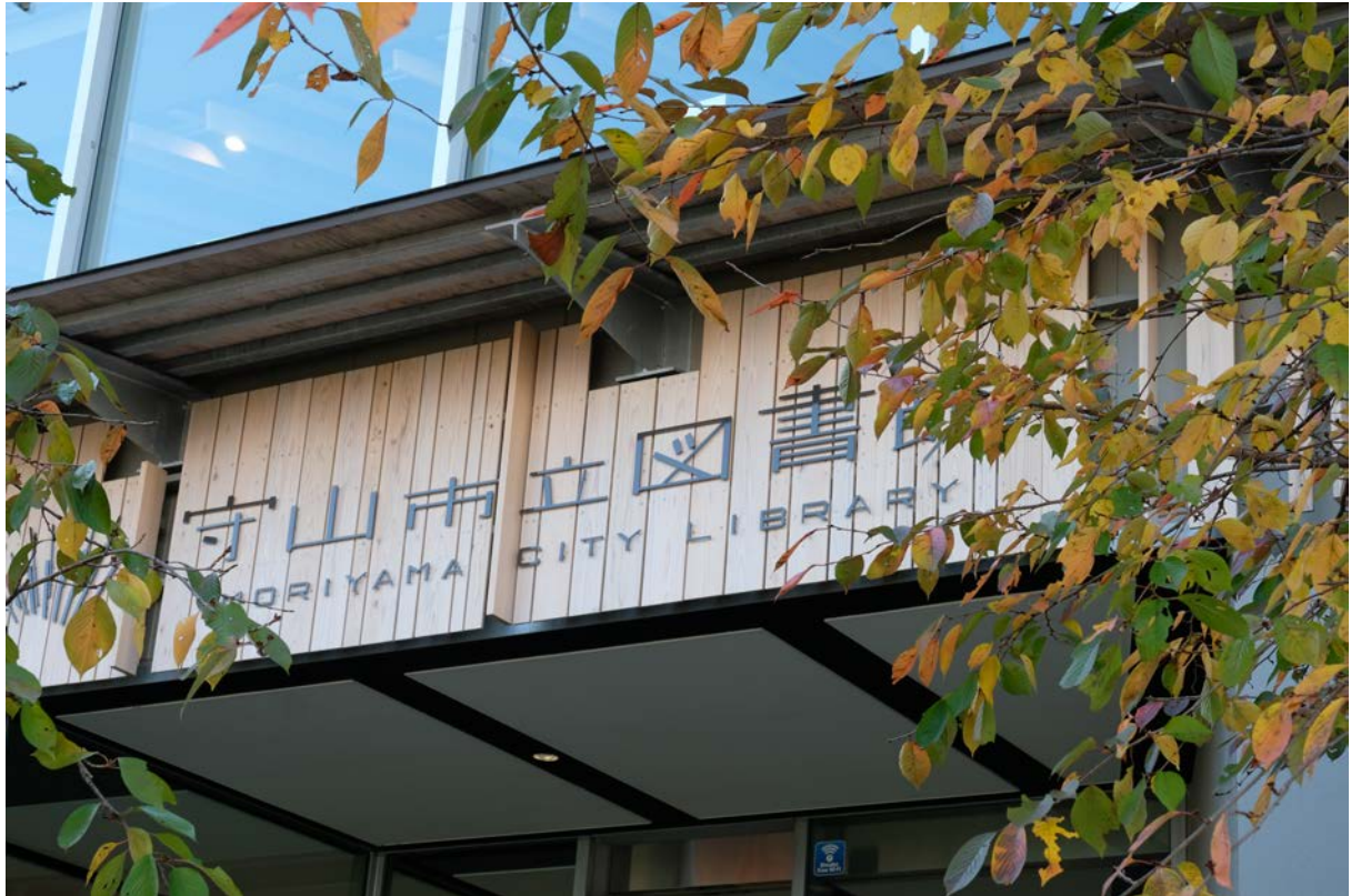
Façade de l'entrée principale
