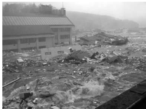
写真11 津波による被災
