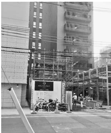
写真 4-4 料亭跡に建設中のホテル（筆者撮影）
