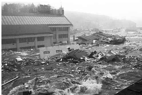
写真3 津波による被災 (提供：女川町)
