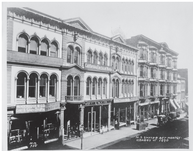
写真2 サター通り支店入居ビル
