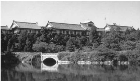
図4-1 奈良ホテル(荒池側から見た)
