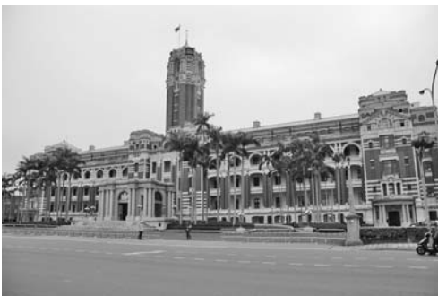
図7 台湾総督府庁舎（現・中華民国總統府庁舎） 長野宇平治・台湾総督府営繕課（森山松之助）設計 台北市 大正8（1919）年 煉瓦造4階建
