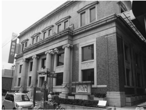
図8 六十八銀行奈良支店（現・南都銀行本店） 長野宇平治設計 大正15（1926）年 鉄筋コンクリート造地上4階地下1階建
