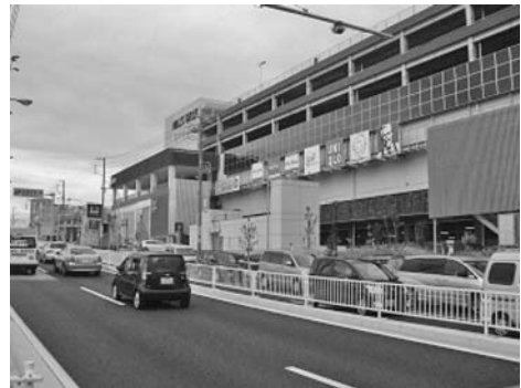
図5-5-1 地下鉄徳重駅前の商業施設 注：丸山撮影（2011年8月31日）
