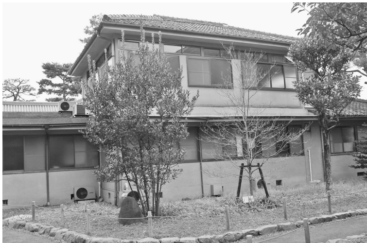
写真1 旧・厚生館（2012年1月撮影）
