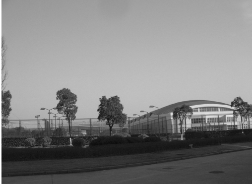
東方緑舟体育訓練基地の建物
