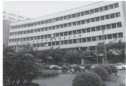
民生分館 「建物全景・図書館は4階」
