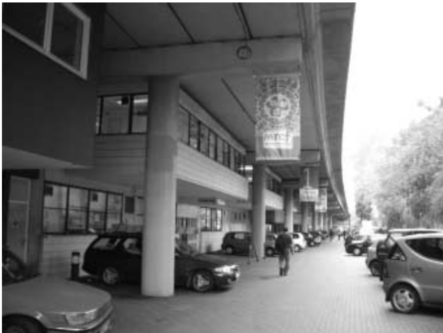
オフィスとして利用されている高速道路高架下
