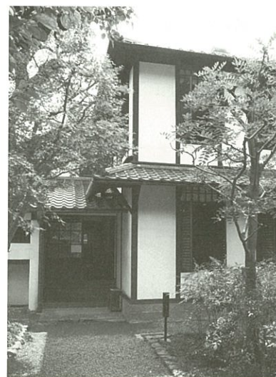
寺町通に面した木戸から玄関への小道
