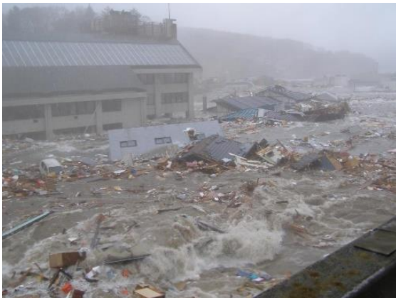
写真3 津波による被災 （提供：女川町）
