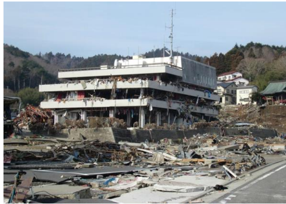
写真 6 津波被害を受けた女川町庁舎 (提供：女川町)
