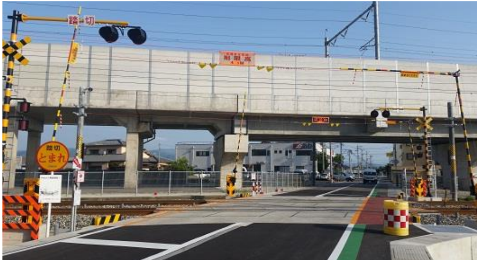
図 2.2 近接する在来線と新幹線設備
